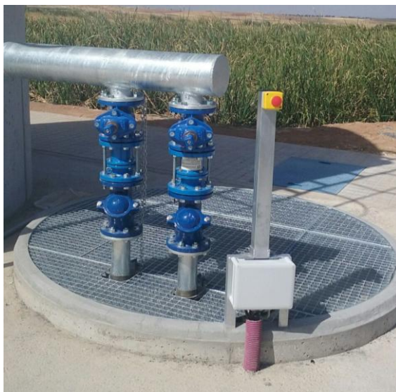
Foto: Arqueta con dos bombas que impulsan el agua al lecho
