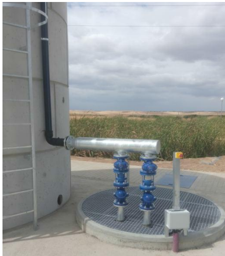
Foto: Conducciones de impulsión
