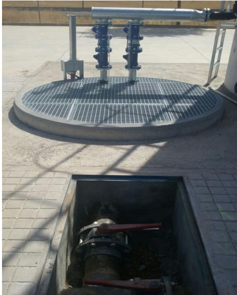
Foto: Recirculación interceptada, mediante sistema de válvulas según necesidades
