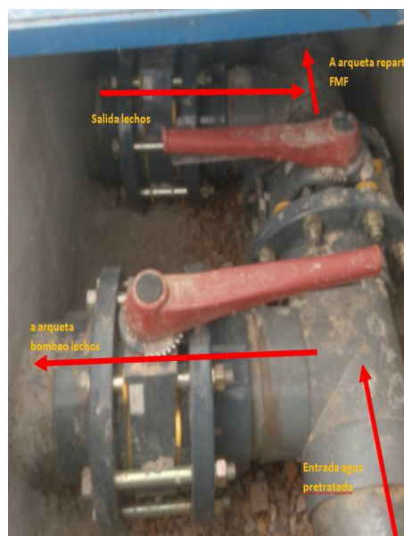
Foto: Conexiones interceptadas entre el caudalímetro y la arqueta de reparto
