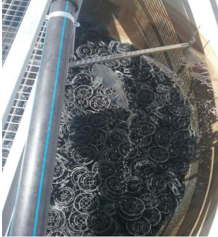
Foto: Distribución del agua mediante el brazo giratorio
