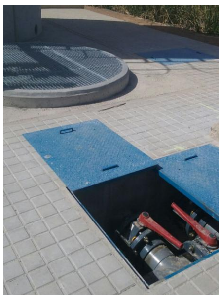
Foto: Conexiones interceptadas entre el caudalímetro y la arqueta de reparto
