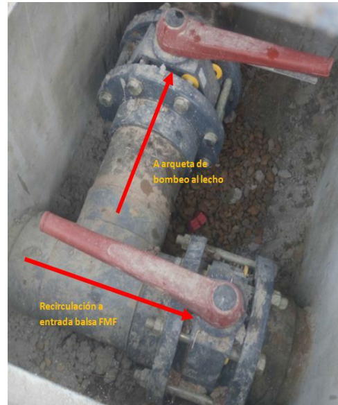
Foto: Recirculación interceptada, mediante sistema de válvulas según necesidades
